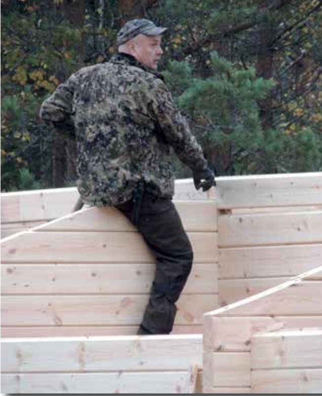
Juhani Toivakka kurkikirren asennuksessa 1.10.2017.
